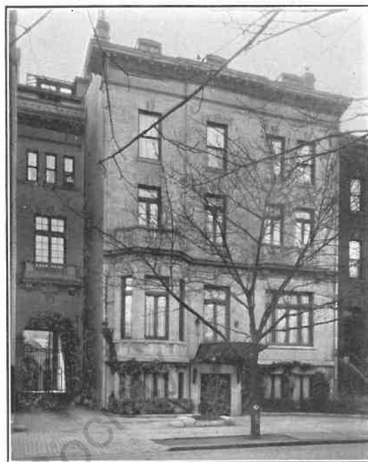
EXTERIOR--1734 N ST. N. W.
